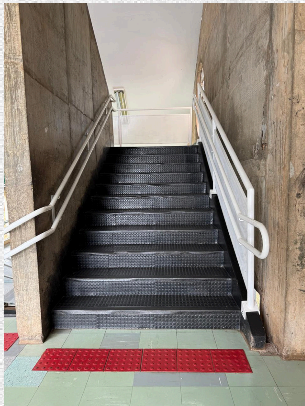
Instalação de Corrimãos e piso tátil
