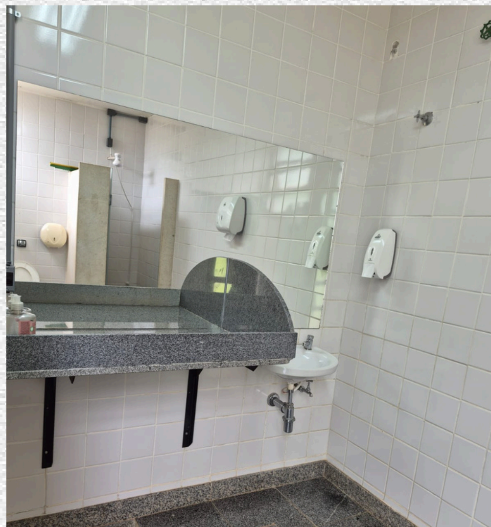
Banheiro com trocador
